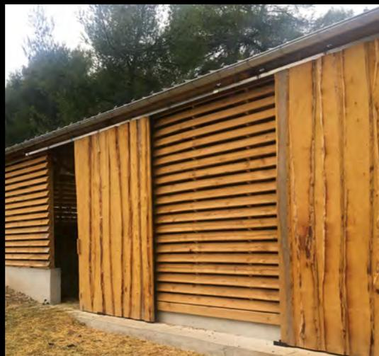
**Structure et bardage en pin d'Alep**
