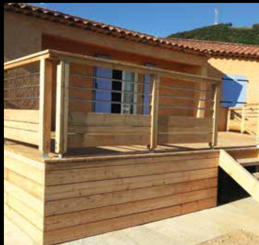
Terrasse et garde-corps en mélèze
