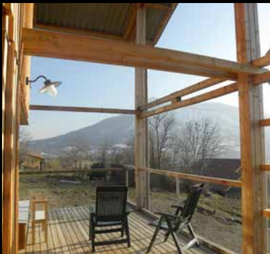
Poteaux et poutres massifs en mélèze Maison individuelle à La Roche des Arnauds
