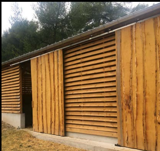
Structure et bardage en pin d'Alep Extension de la chèvrerie communale de Septèmes-les-Vallons (13)
