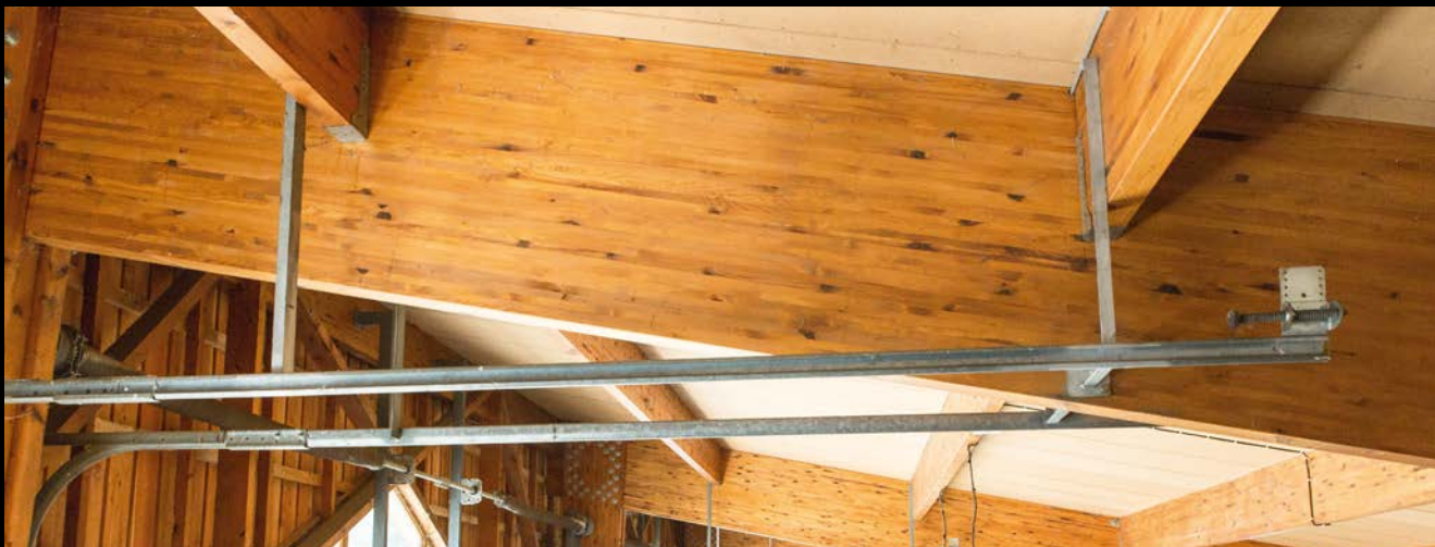
Charpente en lamellé-collé de pin d'Alep, pin noir et pin sylvestre - 1989 Centre forestier de la Bastide des Jourdans (84)
