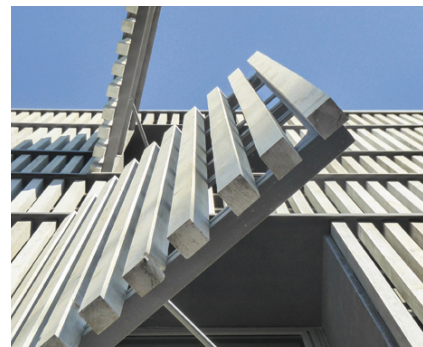
Bardage à claire-voie pré-grisé en pin d'Alep Maison du Parc Naturel Régional des Alpes Maîtres d'œuvre : Bresson Schindlbeck Architectes Associées (Architectes Mandataires) / Fabrica Traceorum (Architecte associé) © David Giancaterina
