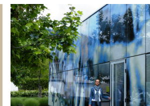
Pavillon de danse Embrun (05) Architecte : Maryline Chevalier
